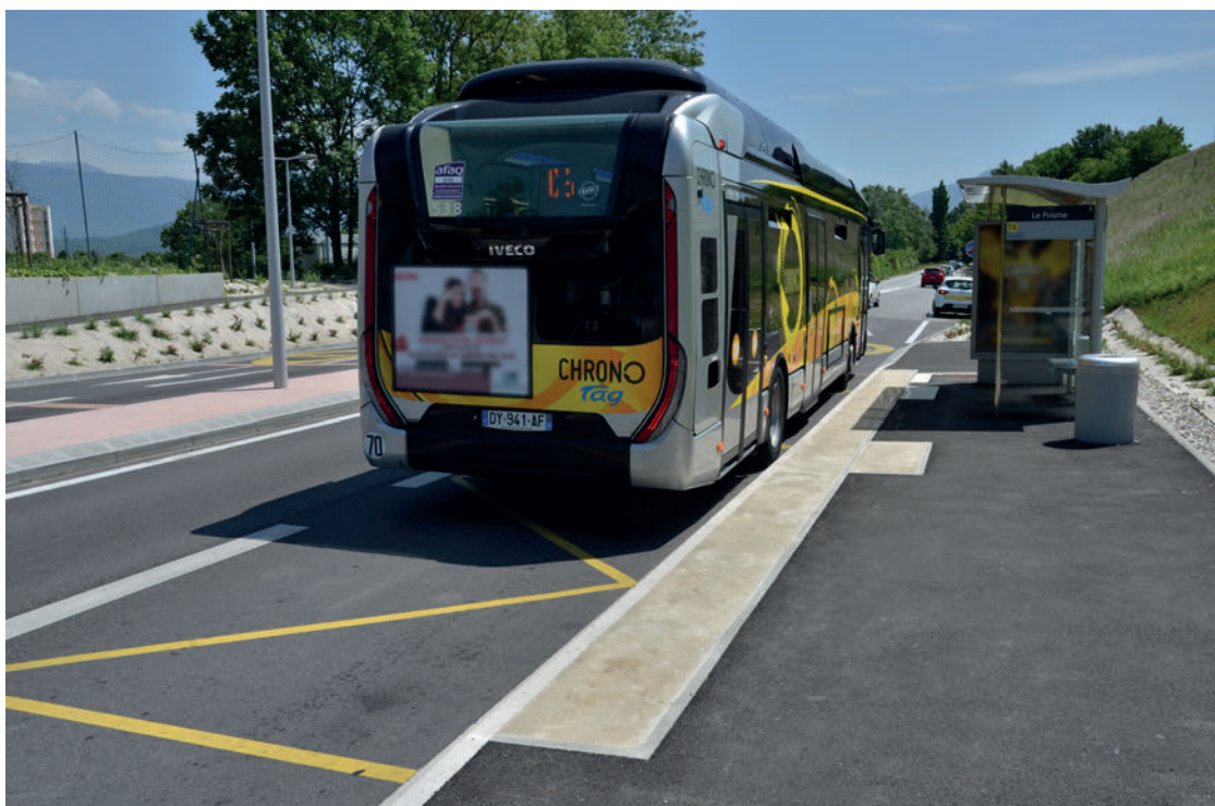
Zone de sécurité contrastée visuellement et tactilement
