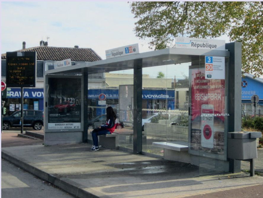
Arrêt de bus comportant plusieurs panneaux publicitaires qui peuvent nuire à la visibilité de l'information utile
