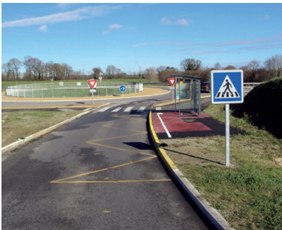
Zone d'attente en asphalté rouge contrastée visuellement par rapport à la chaussée et au cheminement piéton
