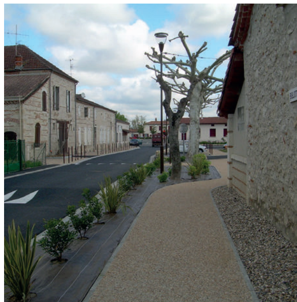
Cheminement libre de tout obstacle comportant une bande technique positionnée entre la chaussée et le cheminement
