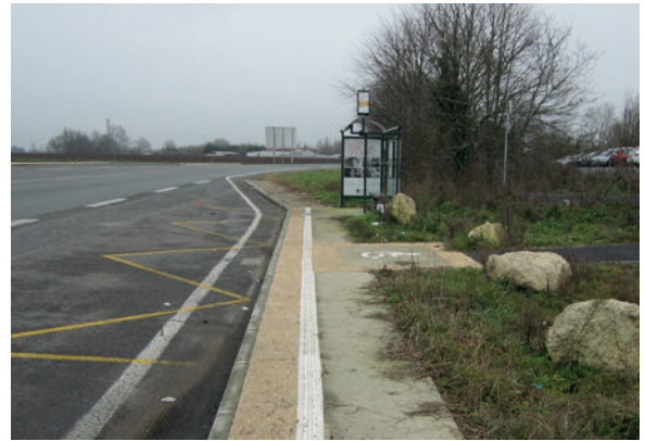
Point d'arrêt non urbain ayant la largeur suffisante uniquement au niveau de la porte du milieu.
