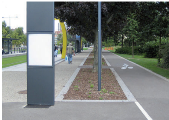
Piste cyclable séparée du point d'arrêt de tramway et du cheminement piéton par une bande composée d'arbres et des poteaux d'éclairage
